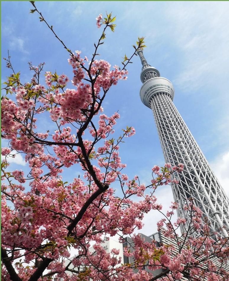
A base da torre se assemelha a uma estrutura "tripé", mas a partir de uma altura de cerca de 350 metros, a estrutura da torre se torna cilíndrica para resistir a ventos muito fortes. Além disso, a torre incorpora recursos de última geração para proteção contra terremotos, como um núcleo central de concreto reforçado.
